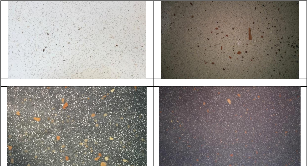
Semina, battitura e frattazzatura del pavimento dopo la stesura di Marmo K Floor_ESA
