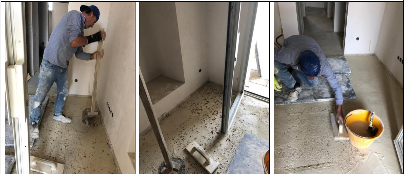
Semina, battitura e frattazzatura del pavimento dopo la stesura di Marmo K Floor_ESA
